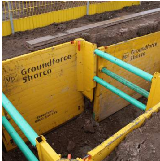
Slika br. 10 – Način zaštite rova
